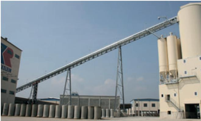
Über das 120 m lange Förderband werden die Rohstoffe direkt aus dem Kieswerk in die Vorratssilos des Mischturms befördert.
