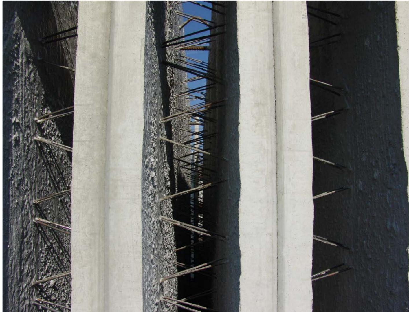
RÖWAPLAN®- Doppelwände sind fast überall wirtschaftlich einsetzbar: Besonders als Kellerwände eignen sie sich hervorragend. Im Wohnungsbau überzeugen sie als preisgünstige und – dank ihrer ausgezeichneten Schalldämmung – komfortable Lösung für Geschoss- und Trennwände.
