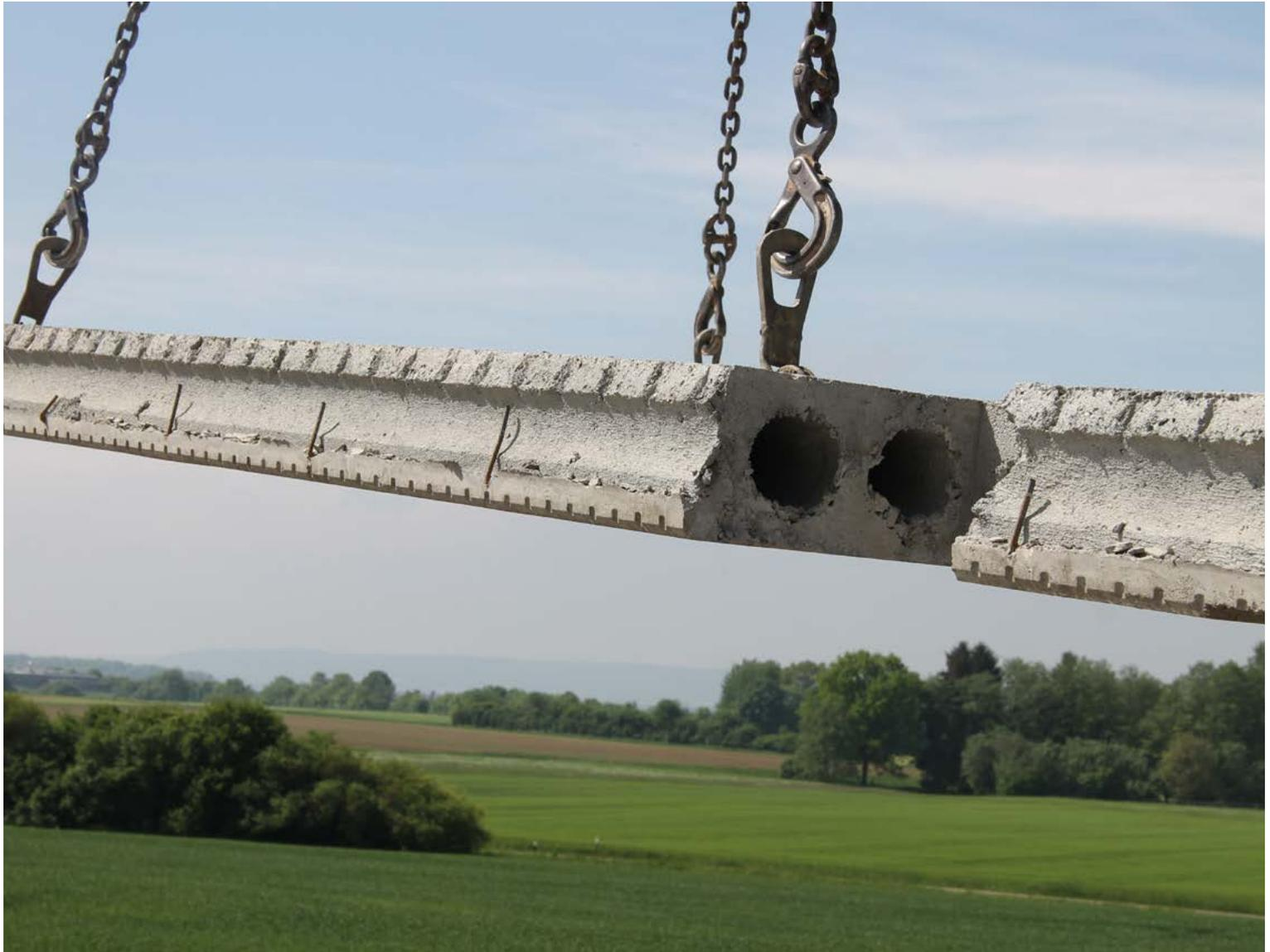
Die RÖCKELEIN SUPRAPLAN® ist eine sogenannte Vollmontagedecke, die bei ausreichend vorhandenen und genügend tragfähigen Auflagemöglichkeiten auf der Baustelle, unterstützungsfrei eingebaut werden kann. Die SUPRAPLAN-Deckenplatten sind als nicht vorgespannte Stahlbeton-Hohldielen konzipiert, die mittels Betonstahl schlaff bewehrt – man sagt auch schlaff armiert – sind. SUPRAPLAN-Vollmontagedecken können auch als 1-Feld-Platte mit Kragarm oder als 2-Feld-Platte hergestellt werden.
